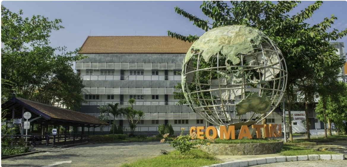
Gedung Departemen Teknik Geomatika ITS.
