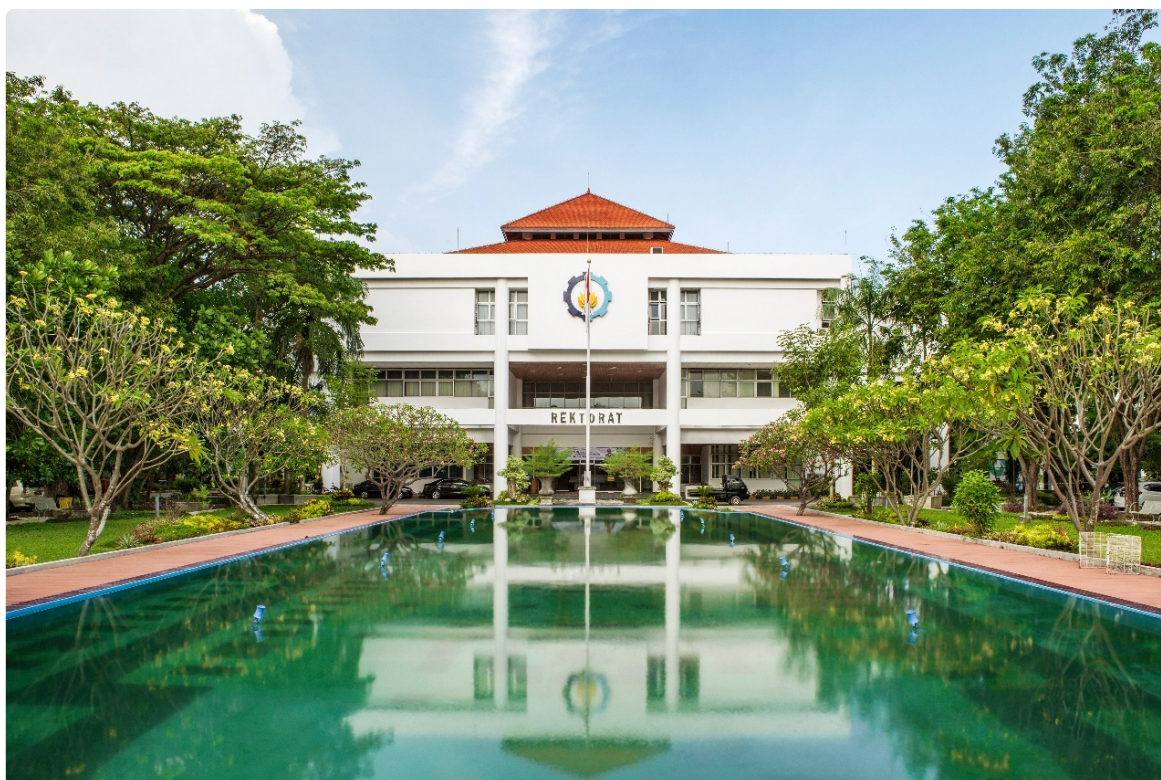
Gedung Rektorat ITS tampak dari depan
